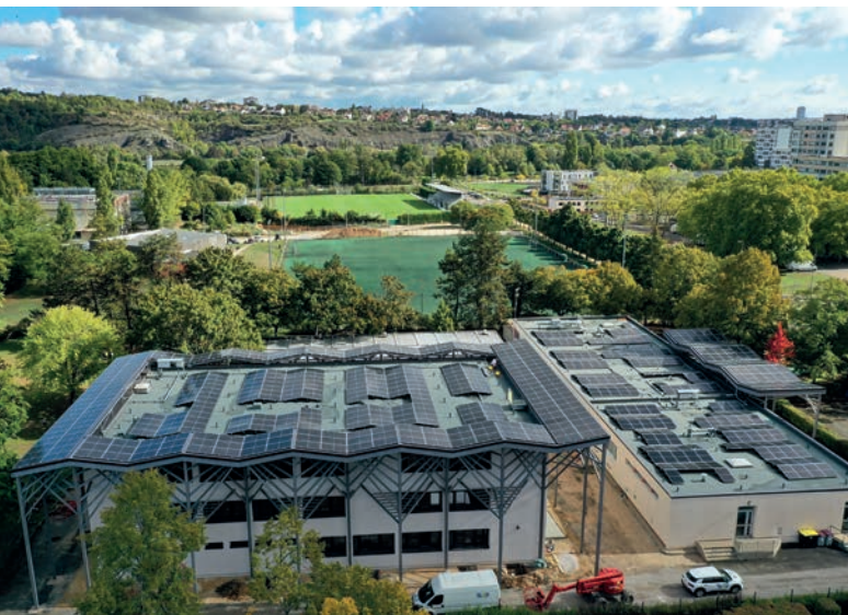
Les panneaux photovoltaïques sur l'école Buffon alimentent en électricité près de 1000 habitants
